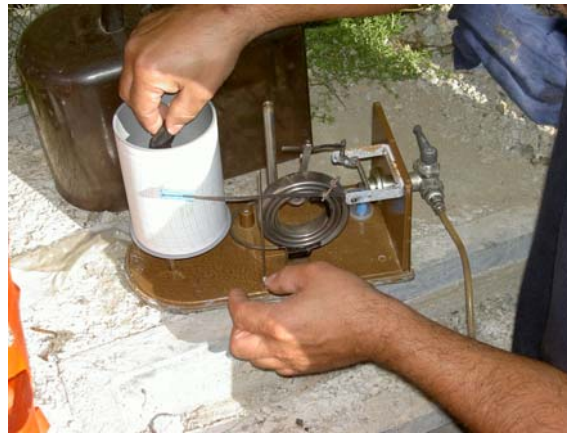
fase di collaudo della condotta rinnovata
