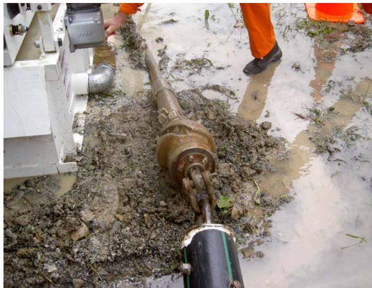
Testa perforante a secco ideale per terreni rocciosi. Fase di alesatura del foro ed inserzione della nuova condotta in PEAD
