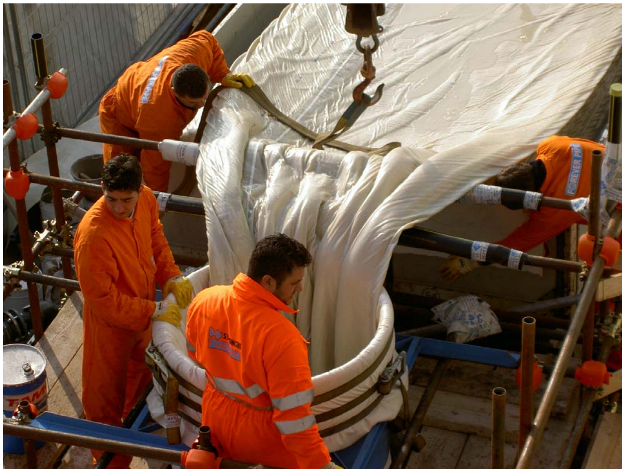
fase di avvio dell'inversione ad acqua di un tubolare termoindurente
