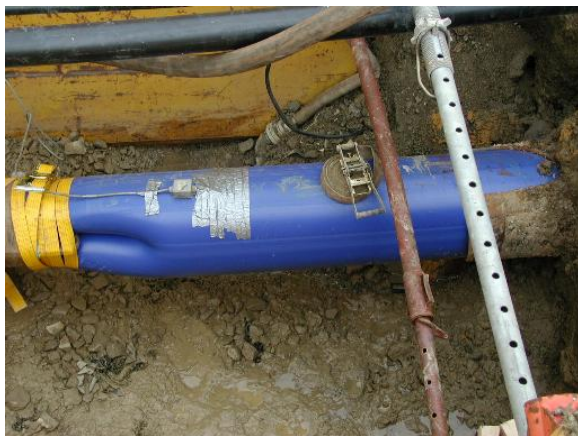
fasi di applicazione del Compact Pipe e realizzazione di una diramazione laterale con giunti meccanici.
