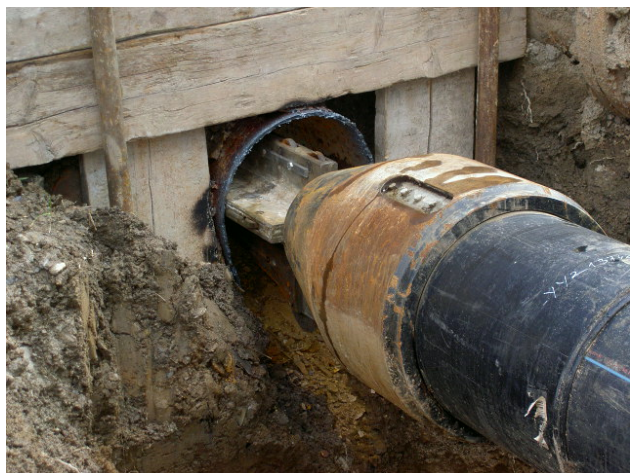
fasi di avvio di un Pipe Splitting
