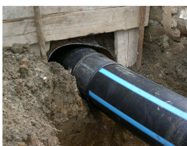
fasi di avvio di un Pipe Splitting
