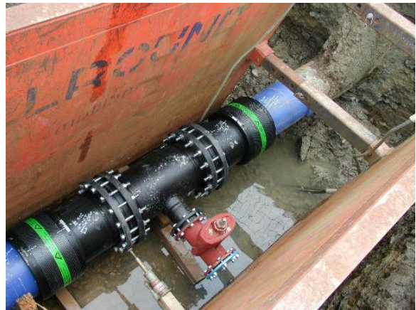
fasi di applicazione del Compact Pipe e realizzazione di una diramazione laterale con giunti meccanici.
