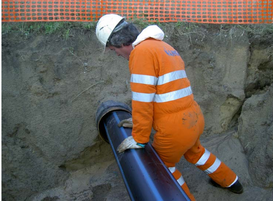
fase iniziale di una inserzione di tubo in PEAD con tecnica di Slip Lining
