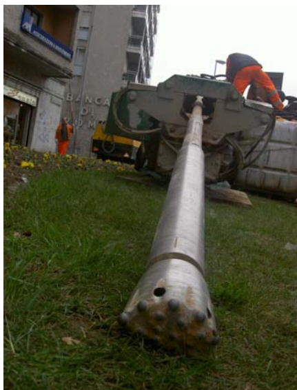
Testa perforante a secco ideale per terreni rocciosi. Fase di alesatura del foro ed inserzione della nuova condotta in PEAD
