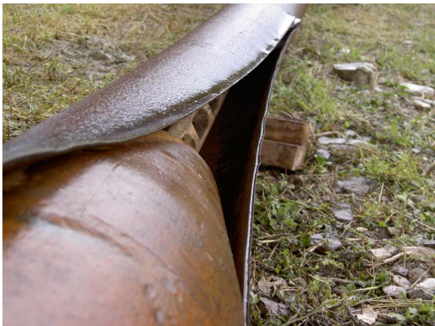
condotta in acciaio sezionata e divaricata da un utensile per Pipe Splitting
