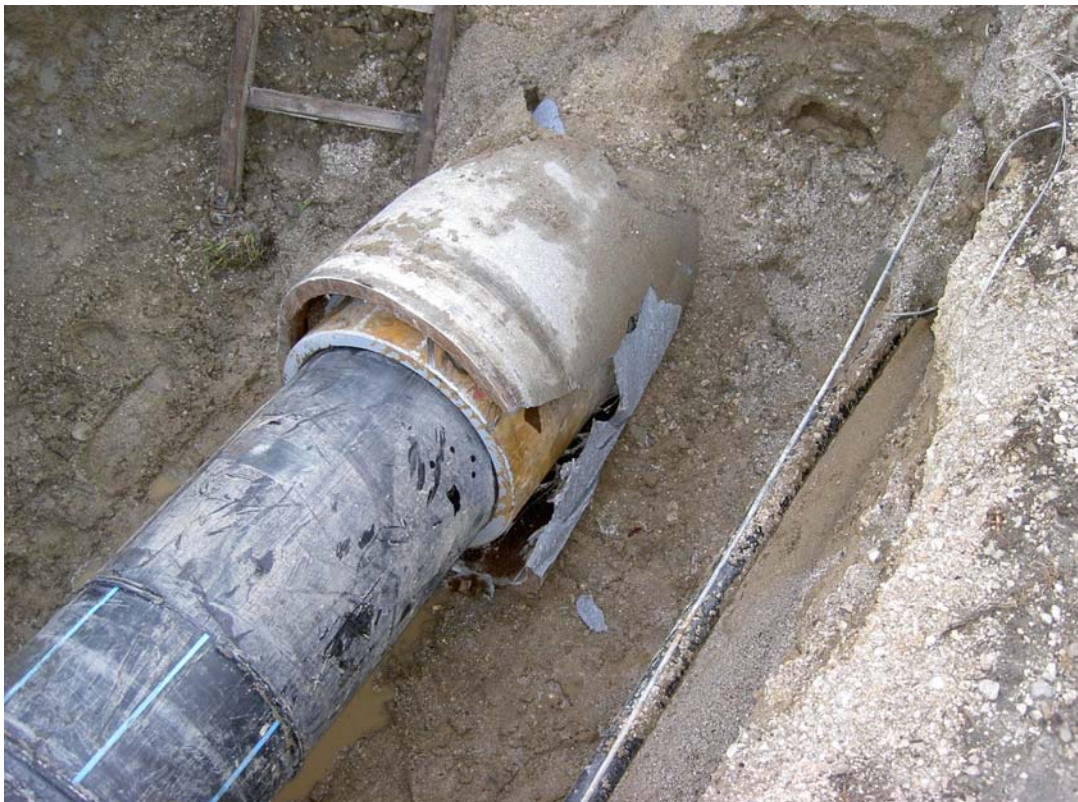
avvio di un Bursting di una condotta idrica in cemento-amianto DN500 mm
