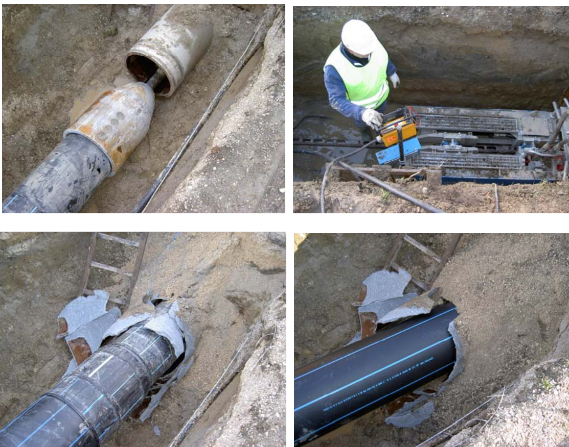
fasi di applicazione di Pipe Bursting
