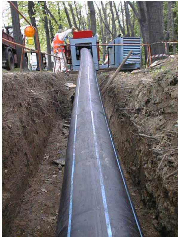
attrezzatura di trafilatura e fase applicativa di Roll Down
